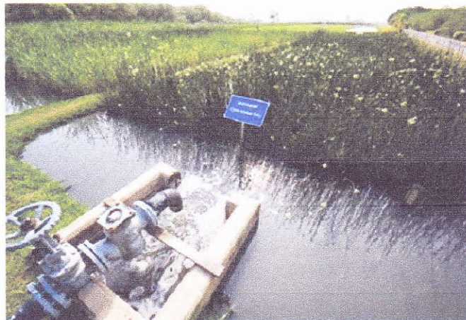
ภาพที่ ๘ ภาพตัวอย่างระบบการบำบัดน้ำเสียแบบบึงประดิษฐ์
